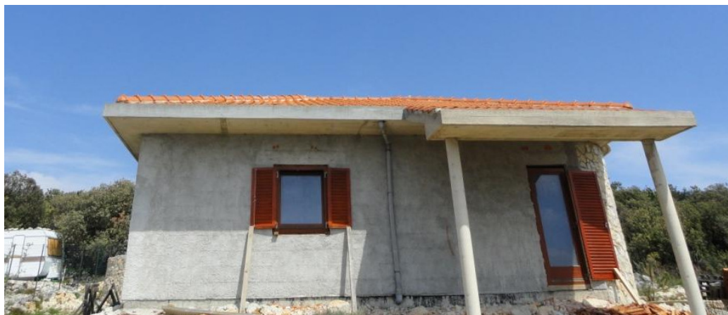
Slika 9/3. Streha krova „drži“ stolariju u hladu
